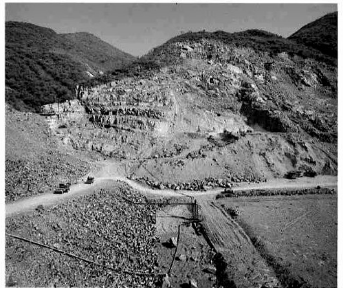
Arriba, abatimiento de la ladera de la margen izquierda de la presa; abajo, planta de agregados.
