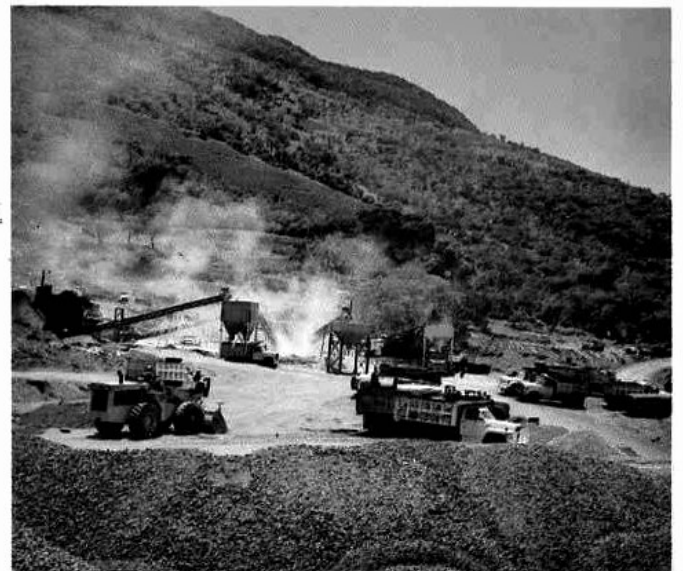
Arriba, abatimiento de la ladera de la margen izquierda de la presa; abajo, planta de agregados.
